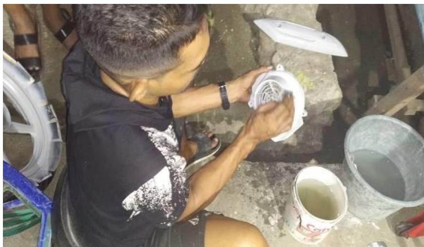
Gambar 3. Proses Pengampalasan yang masih manual
