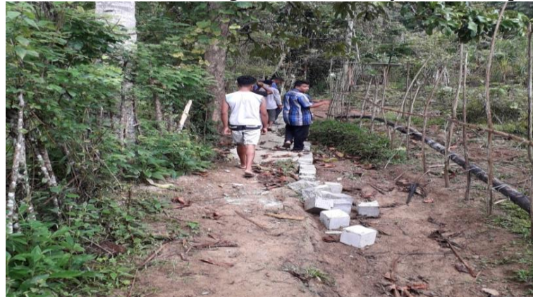
Gambar 4. Peletakan kubus beton sebagai canstien menuju titik akhir panjang 28 meter
