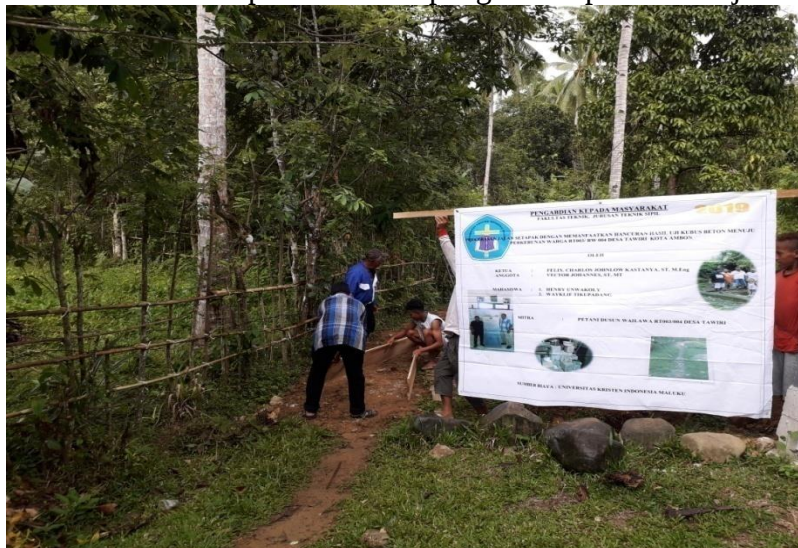
Gambar 2. Penetapan titik awal pengecoran perkerasan jalan
