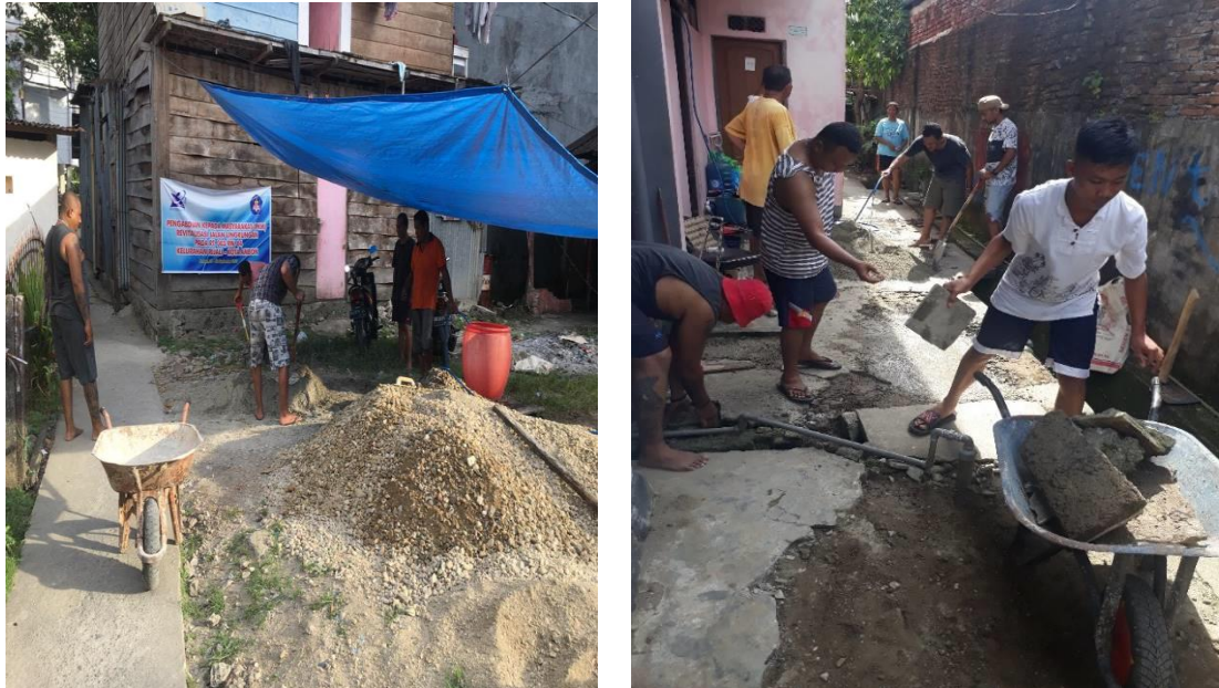
Gambar 2. Pelaksanaan Pekerjaan Jalan dan Drainase Lingkungan.
