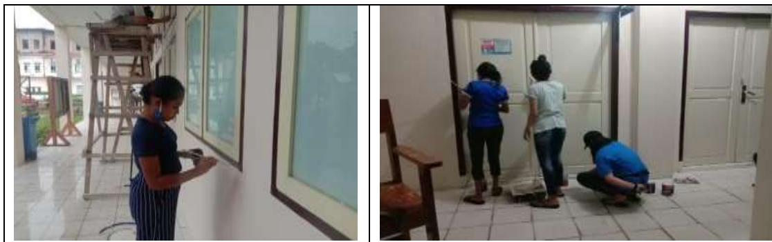
Gambar 4. Proses Pengecatan Dinding Ruang Kuliah. (Dokumentasi Tim )
