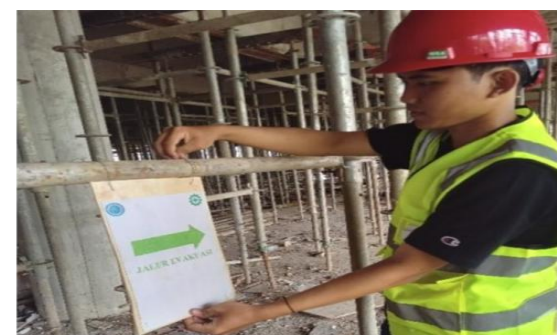
Gambar 6. Pemasangan Safety Sign
